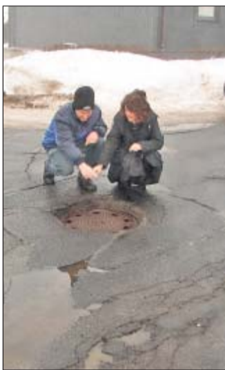
Der Gullydeckel in der Friedensstraße war mal ebenerdig. Feuerwehrchef Uwe Fröhlich und Bürgermeisterin Petra Enders schauten sich gestern die Straßenschäden an. Foto: H. Schulze
